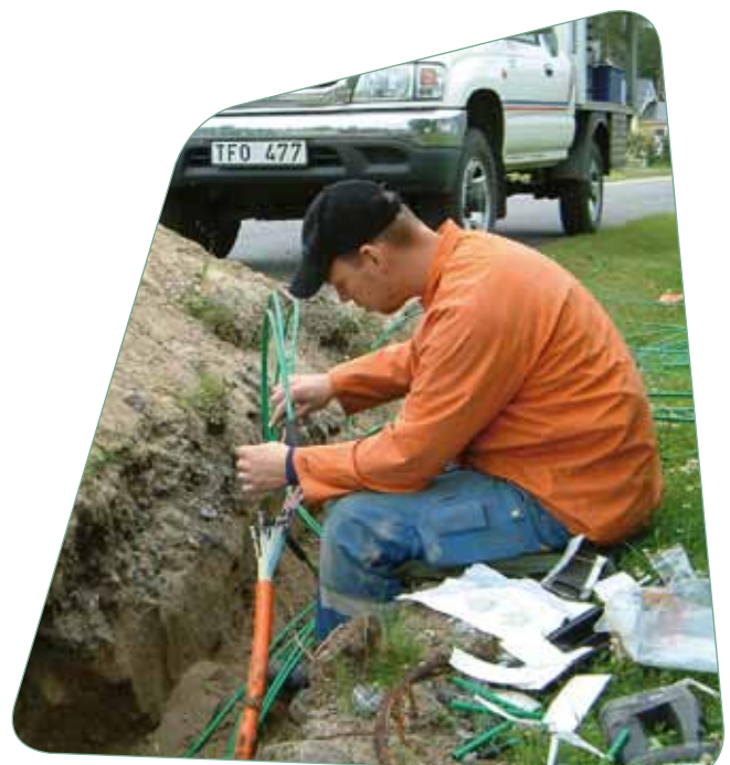
Bredbandsinstallation på gång. Foto: Kenneth Flodin
