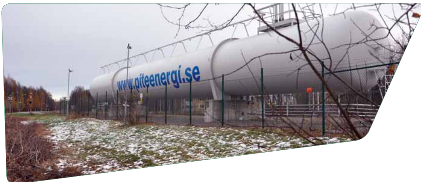
En gasoltank utanför PiteEnergis anläggning. Foto: Kenneth Flodin
